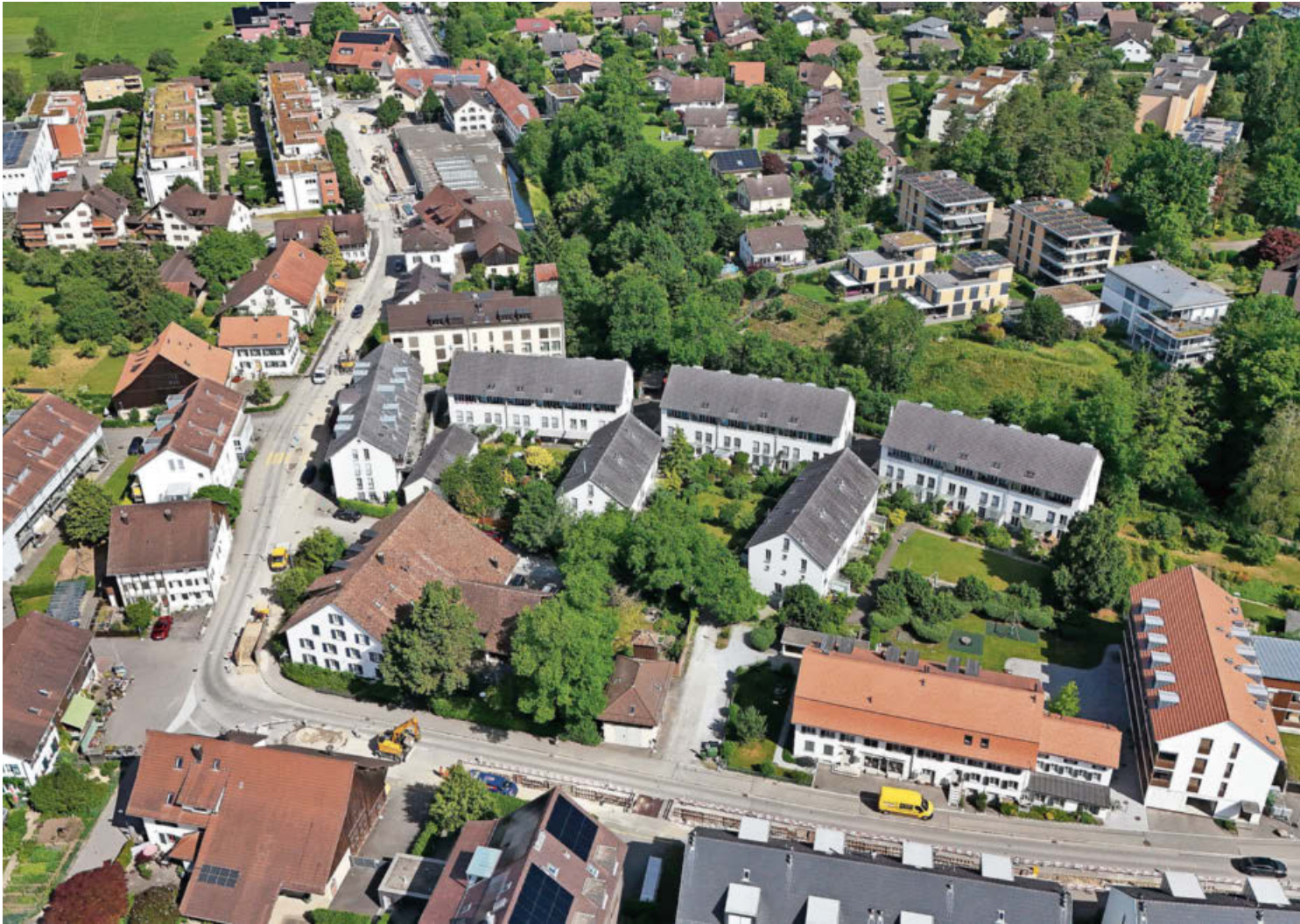
Die Seestrasse in Niederuster. Bis Ende Jahr sollen die Sanierungsarbeiten abgeschlossen sein. Dann folgt im Frühjahr als Abschluss der Einbau des Deckbelags.
